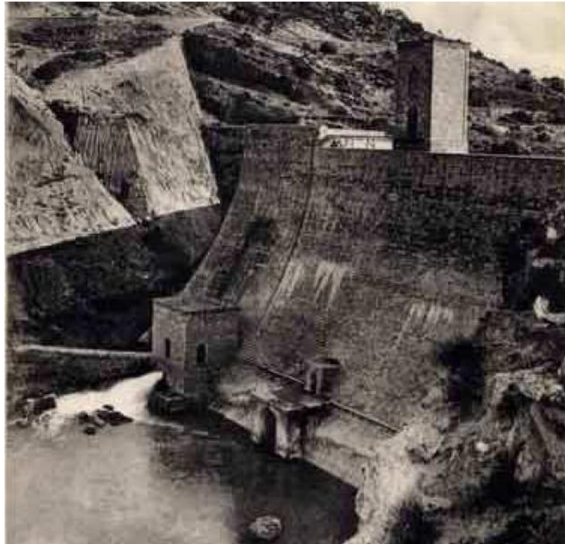
Figure 3-3 : Barrage de Cheurfas, après travaux : nouvel appui RD vers l'amont ( http://sigoise.free.fr )
