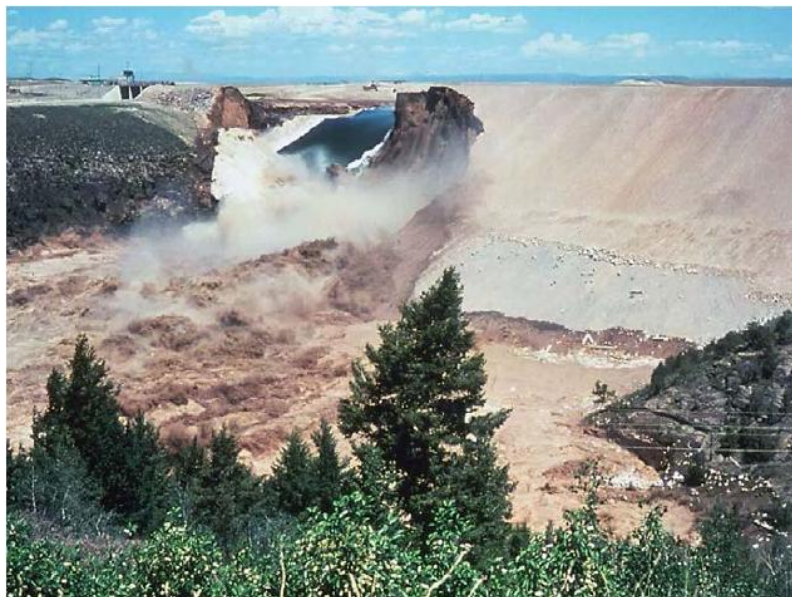
Figure 4-1: Rupture du barrage en terre de Teton (Idaho) en 1976. (Christophe Ancey, 2014)
