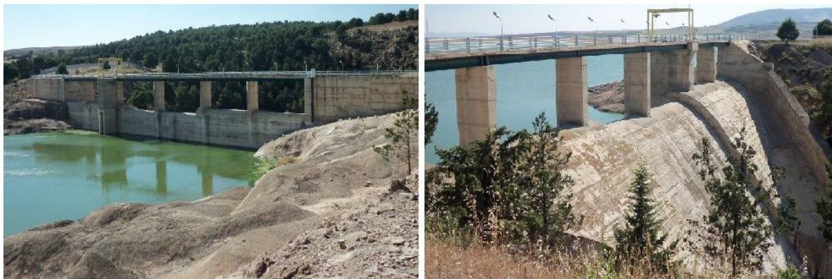
Figure4-3: La digue de barrage Hammam Grouz
