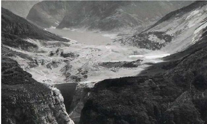
Figure 2-1 : Barrage du Vajont après le mouvement de terrain du 9 octobre 1963. (Christophe Ancey,2014)
