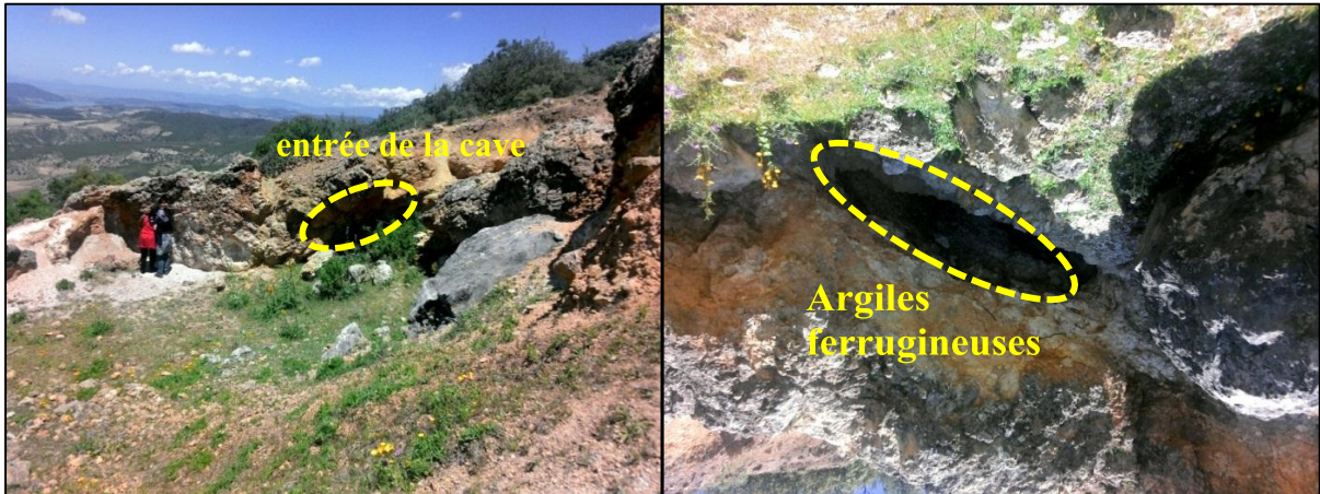
Figure 37: Cavité karstique de taille réduite au sein de la Mine de kaolin
