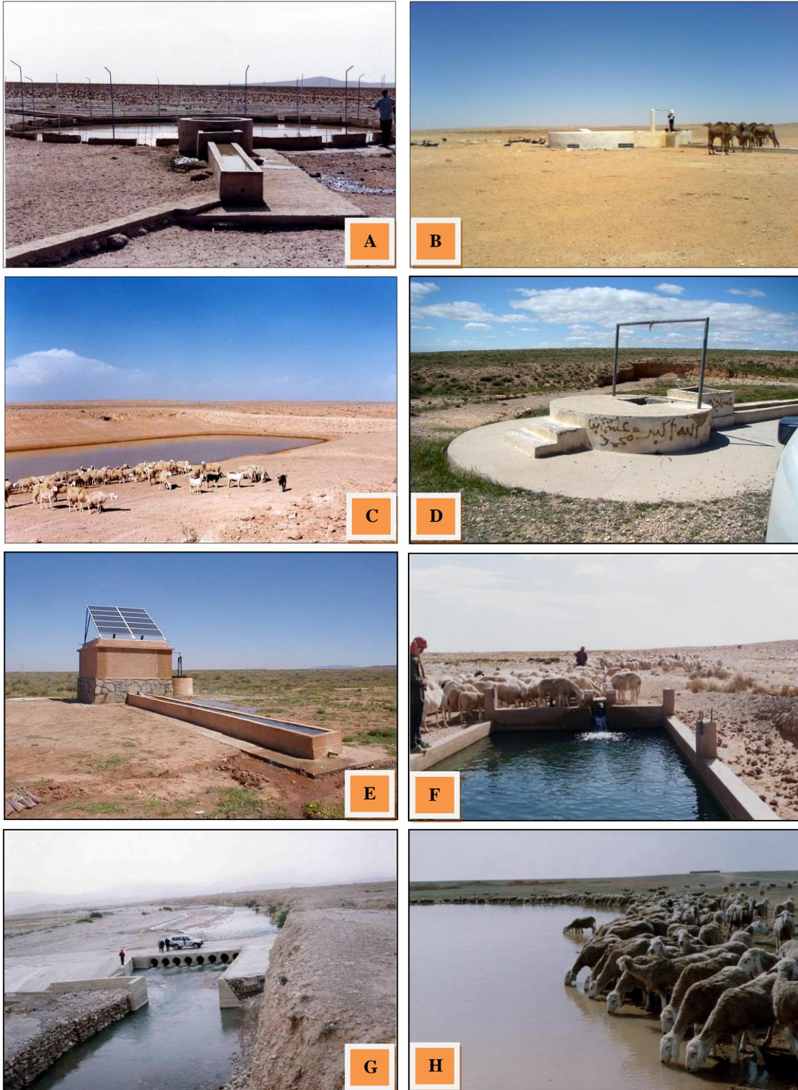
**Planche III-1 : Les différents travaux d'aménagements steppiques réalisés par le H.C.D.S. : (A) Djoub ouvert, Telemcen ; (B) Djoub couvert, Laghouat ; (C) Mare, Djelfa ; (D) Puits pastoral, M'Sila ; (E) Forage, El Bayadh ; (F) Captage de source, El Bayadh ; (G) Ouvrage de dérivation des eaux de crues, Laghouat ; (H) Mare, Nâama. (Cliché H.C.D.S., 2008)**
