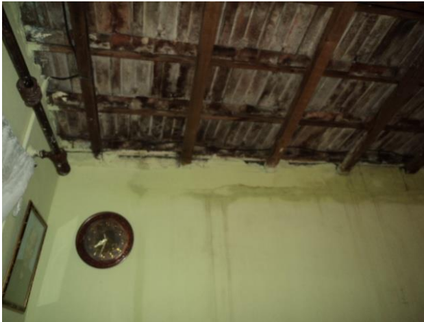
Figures 53, 54 : Infiltration d'eau.
