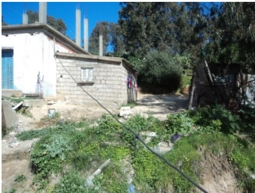
Figure 71 : Habitat informel en dur + une extension anarchique en dure sur une des façades latérales.
