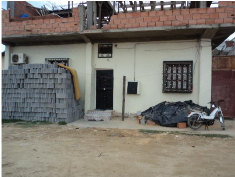
Figure 18 : Maison en cours de reconstruction en dur.
