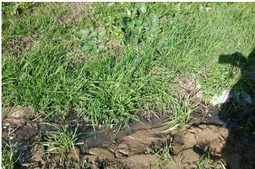
Figure 97 : Egout à ciel ouvert.
