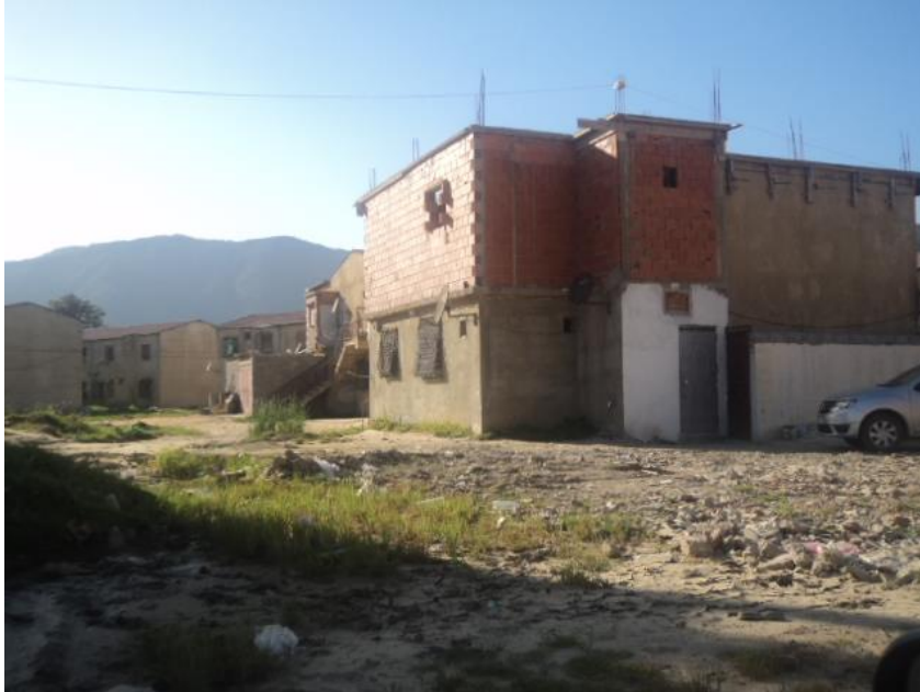
Figure 72 : Logement rural complètement transformé.
