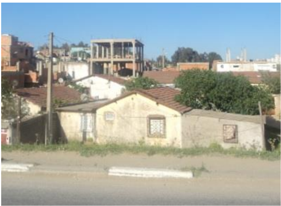
Figure 21: Extension en dure et sommaire de la même maison au même niveau (RDC)
