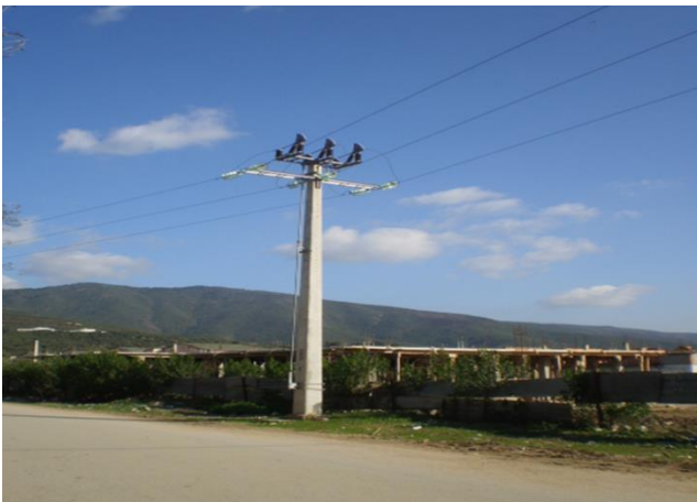
Figure 86 : Poteau moyenne tension.
