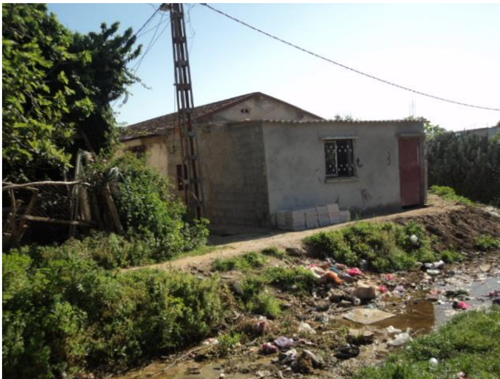
Figure 22 : Extension sommaire de la maison
