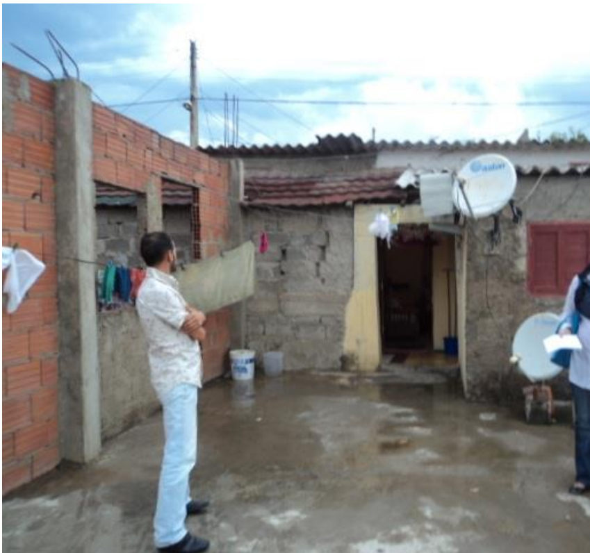
Figures 24, 25 : Extension en dure et sommaire de la même maison à différents niveaux (RDC et R+1)
