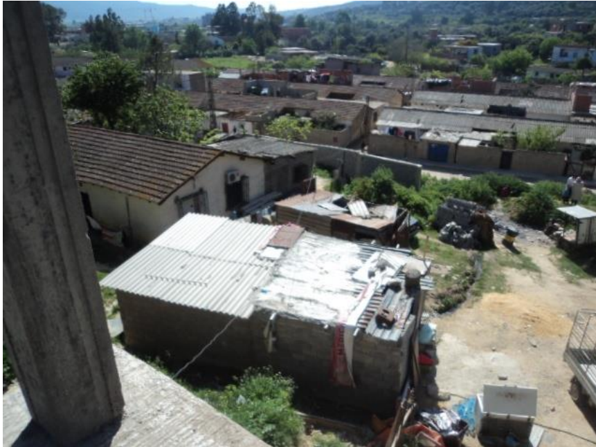
Figure 26 : Extension informelle de la maison mère + l'ajout d'un bidonville
