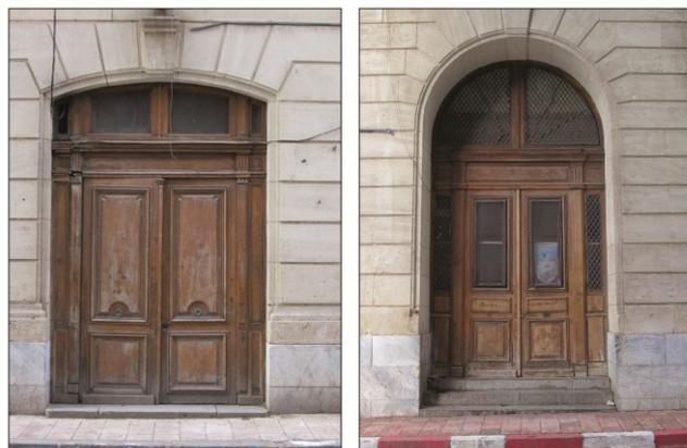
Figure 4-19 : portes classiques à panneaux.
