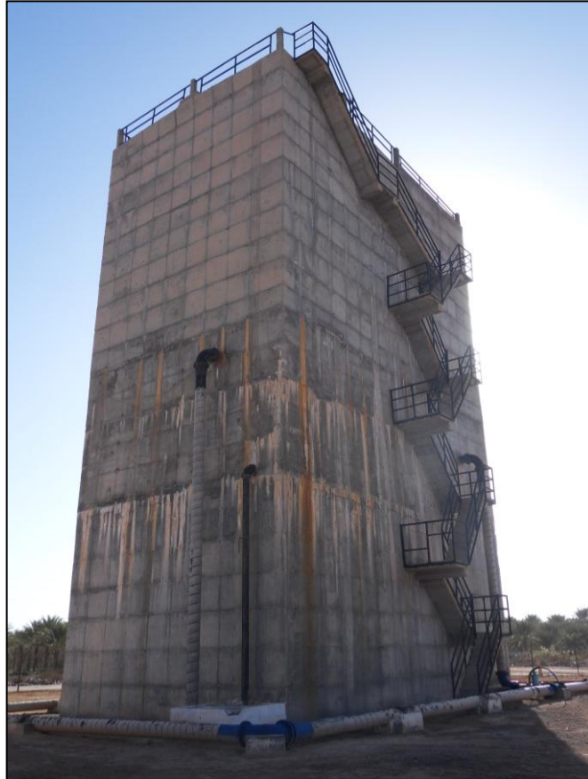
Photo : Station de refroidissement des eaux géothermales
