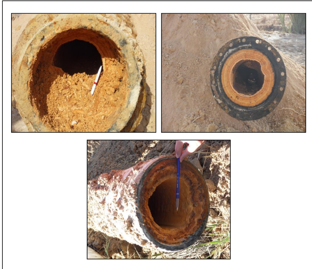
Figure 7-1 : Effets d'entartrage sur les canalisations (Oued Righ)
