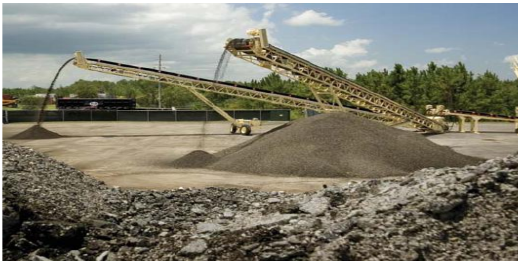
Fig.3.4 : Stockage des agrégats d'enrobé avant l'essai
