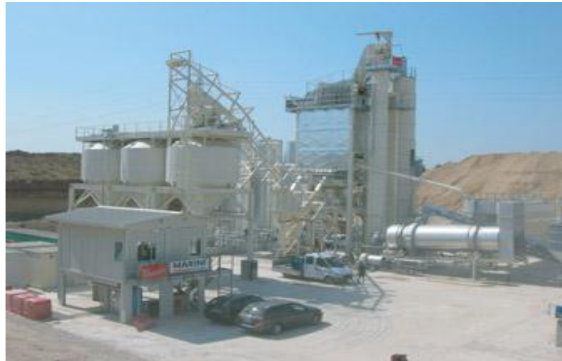
Fig.1.25 : Vue d'ensemble d'un poste à chaud discontinu
