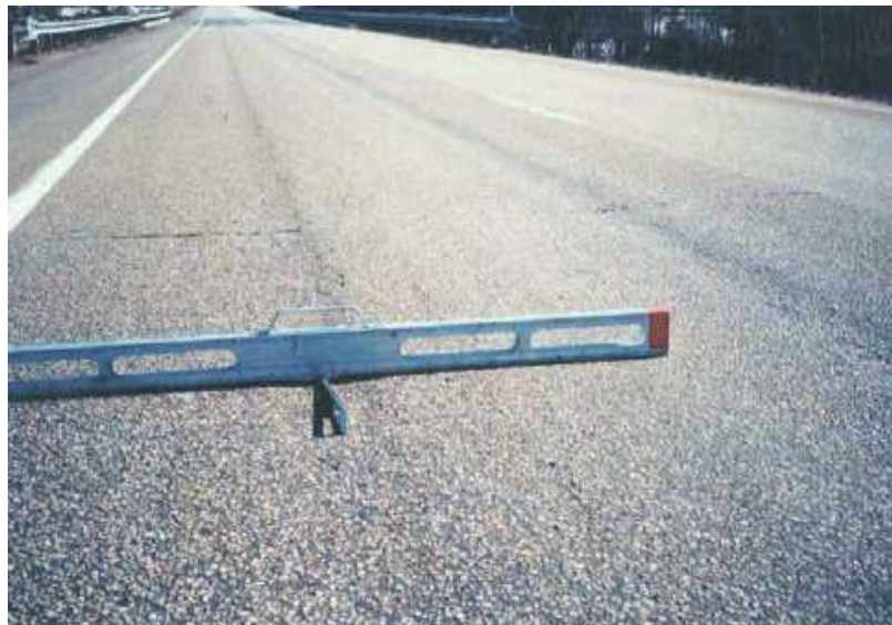
Fig.1.22 : b- Cas d'orniéage d'usure « orniéage à petit rayon »
