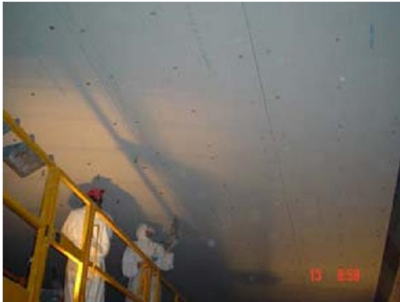
Figure I.31. Installation d'une protection thermique rapportée sur la dalle d'un tunnel.
