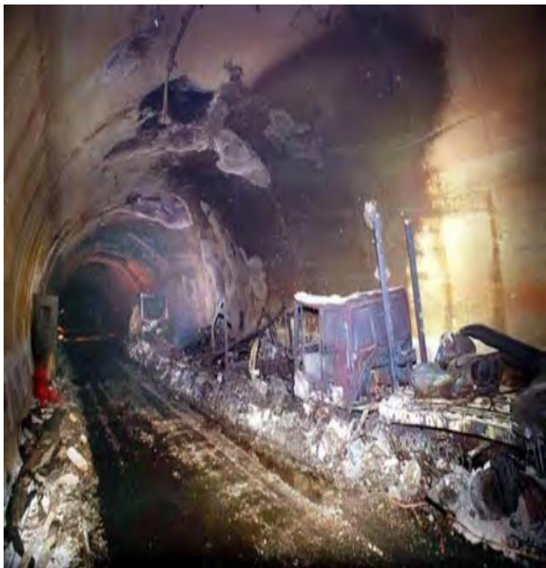
Tunnel sous la Manche [28].
