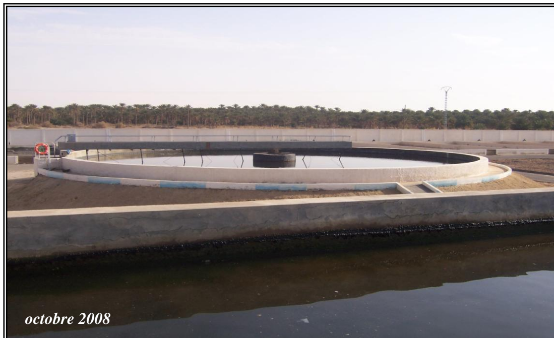
Fig.42 : Vue de la station d'épuration de Touggourt
