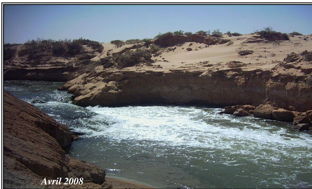
Fig.44: Destruction des berges du canal en sable due aux turbulences à Boufeggoussa
