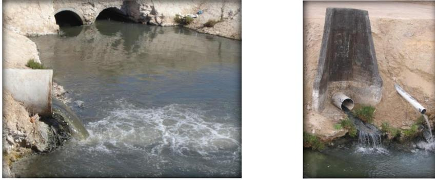
*Photo 2: Rejet d'eaux usées sans traitement directement dans le canal.*
