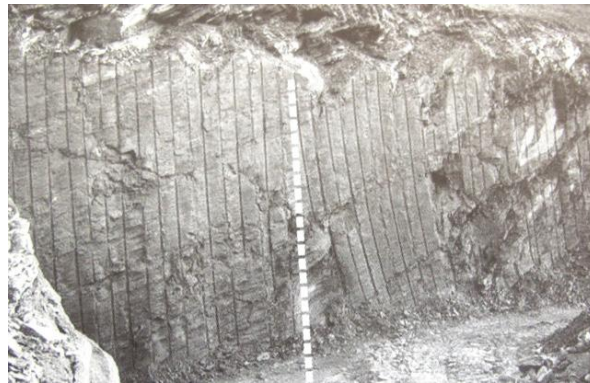
Fig. I.28: Déviation des forages due aux discontinuités (à gauche: avec tige guide pour limiter les déviations; à droite: sans tige guide). (Meyer, 2002 [97]).
