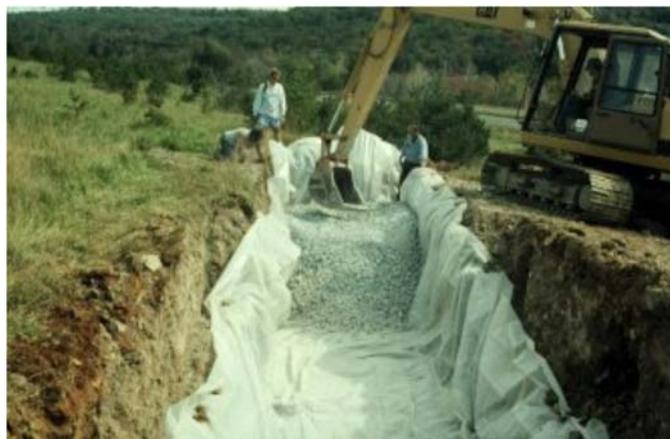
Fig.70. Drain calcaire anoxique en construction (tiré de Brunet 2000)
