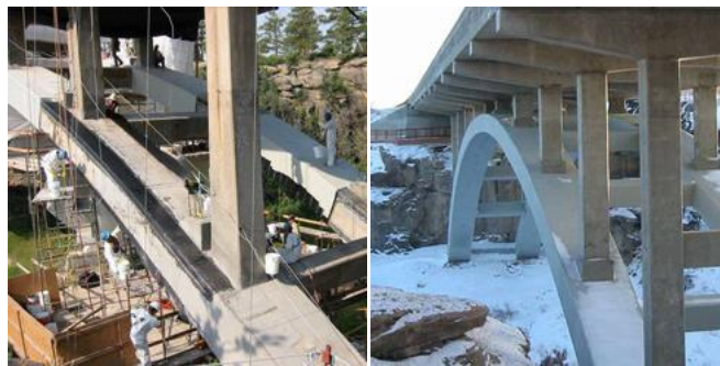
Fig. 1.12 Renforcement des infrastructures de transport par matériaux composites : pont avec renforcement [2]
