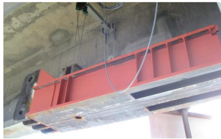
Fig.1.18 Renforcement par Tissus en Fibres de Carbone TFC d'une poutre en acier
