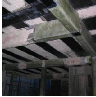
Fig.1.17 Renforcement par Tissus en Fibres de Carbone TFC d'une poutre en béton armé.
