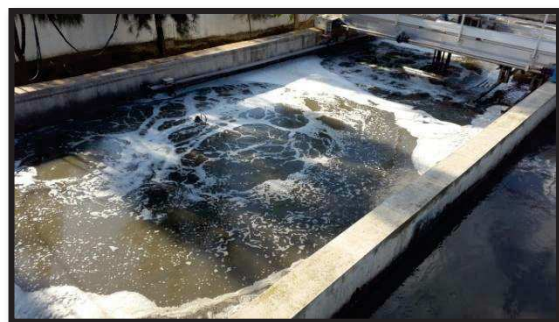
Figure 3. Le prétraitement primaire des eaux usées (STEP Guelma).
