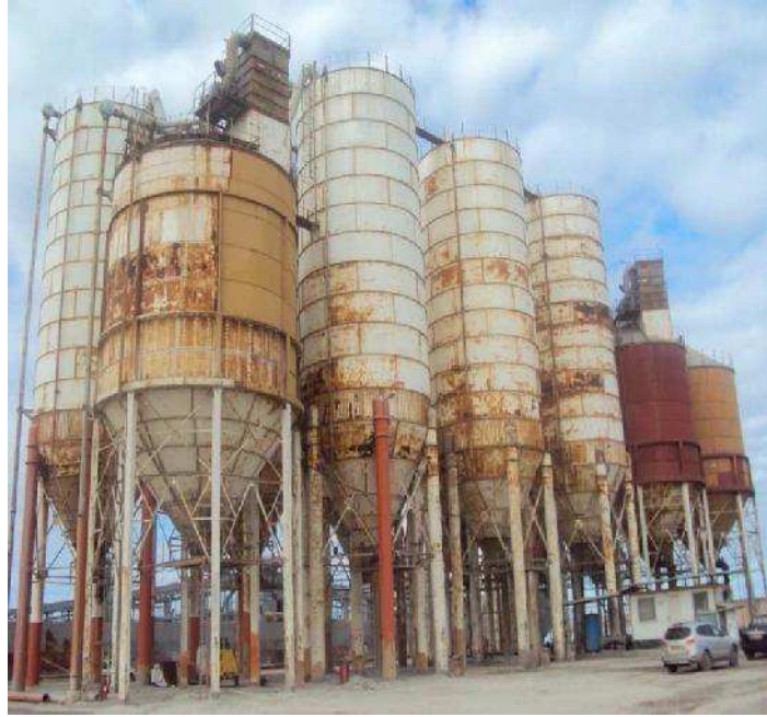
Fig.V.24. Photographie de la batterie des 12 silos
