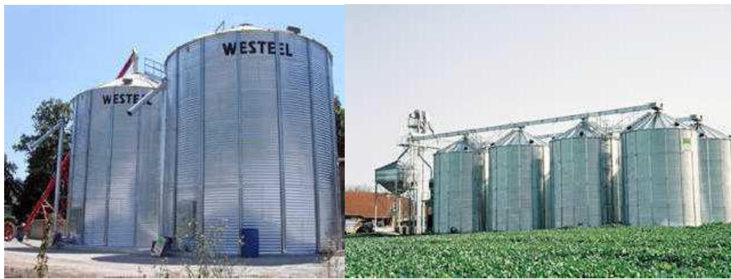
Fig. III.1. Silos de stockage des grains. [17]
