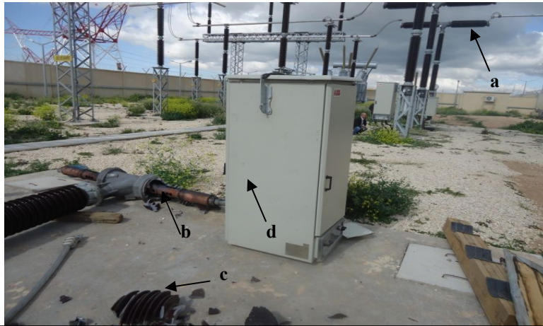
Fig (1.5) : Prise photo de la zone d'incident, a- pôle saint de disjoncteur 400kV, b- pôle ph0 explosé et calciné, c- fragments de porcelaine, d- armoire de commande de la self [31].
