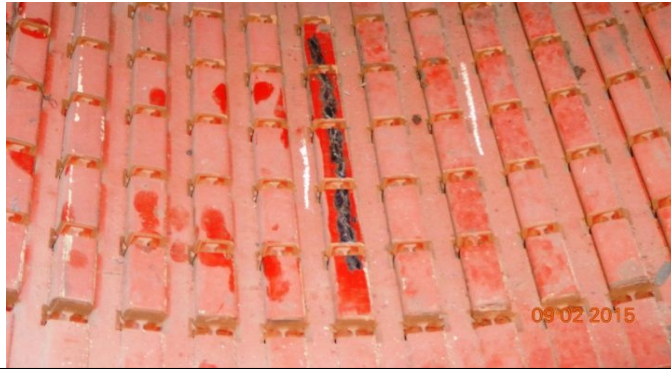
Fig (1.14) : Stator GR4 de la centrale Annaba : usure d'une partie du noyau ferromagnétique par échauffement excessif [34].
