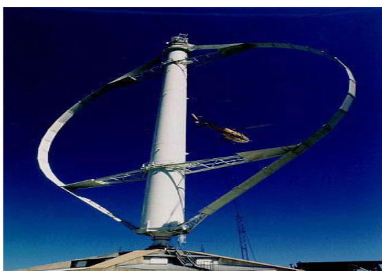
Figure.1.3 Aérogénérateur à axe vertical (structure de Darrieus) [6].
