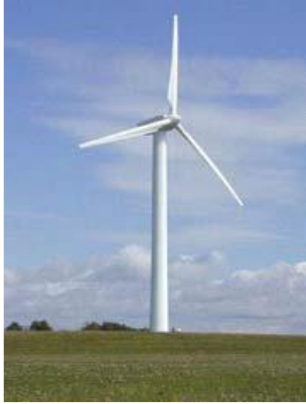
Figure.1.2 Aérogénérateur à axe horizontal.
