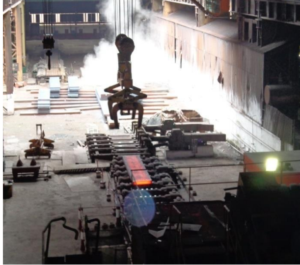
Figure 54 : manutention des brames
