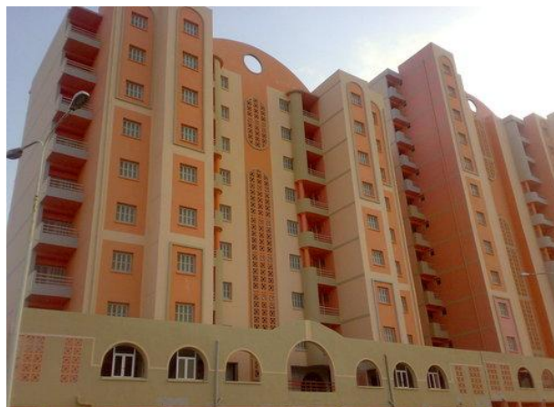
Figure 23. Logements location vente « A.A.D.L» à la ville de Skikda.
