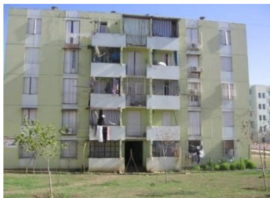
Figure 29. Photo d'un bâtiment de la cité « SO.NA.TI.BA ».
