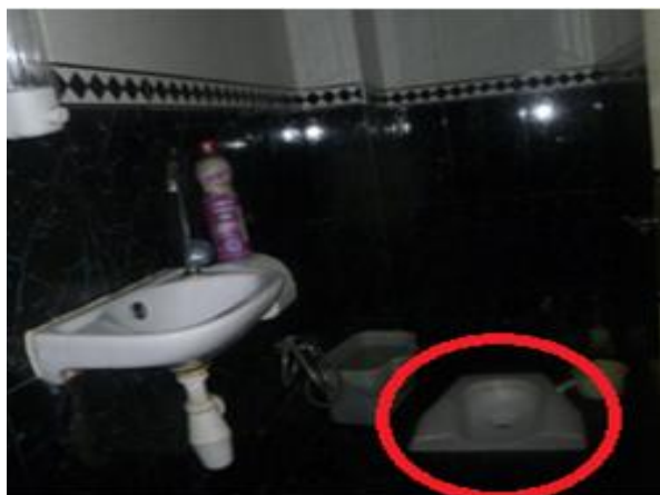
La reconversion du WC à l'anglaise en WC à la turque logement n° 17.
