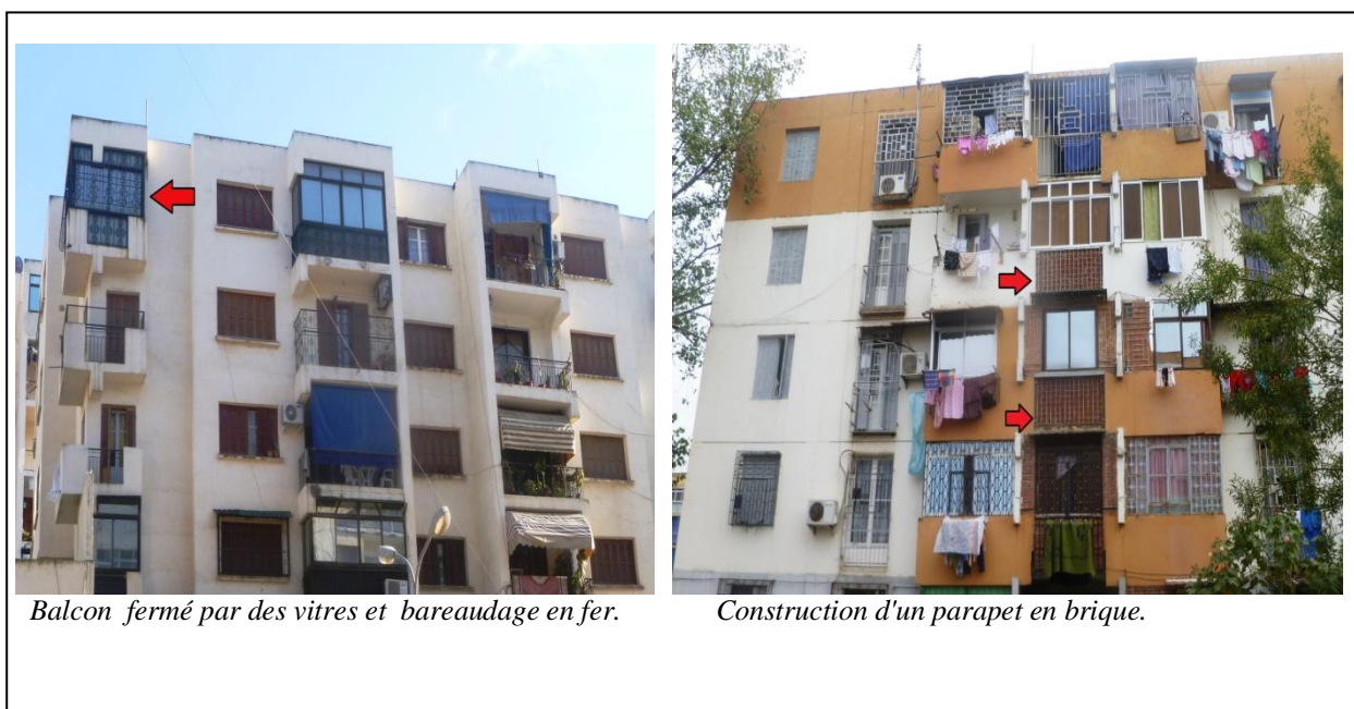
Figure 60 . La fermeture d'éléments architecturaux ouverts sur l'extérieur.
