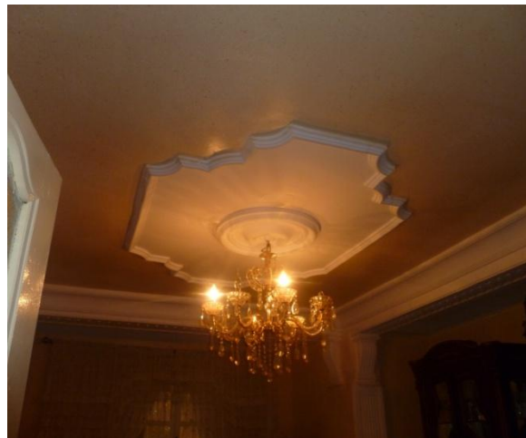
Faux plafonds en Placoplâtre dans le séjour, logement n° 36.
