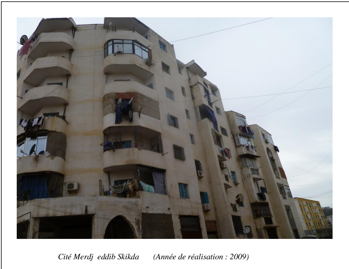
Figure 69. Dégradation physique du logement collectif récemment construit.
