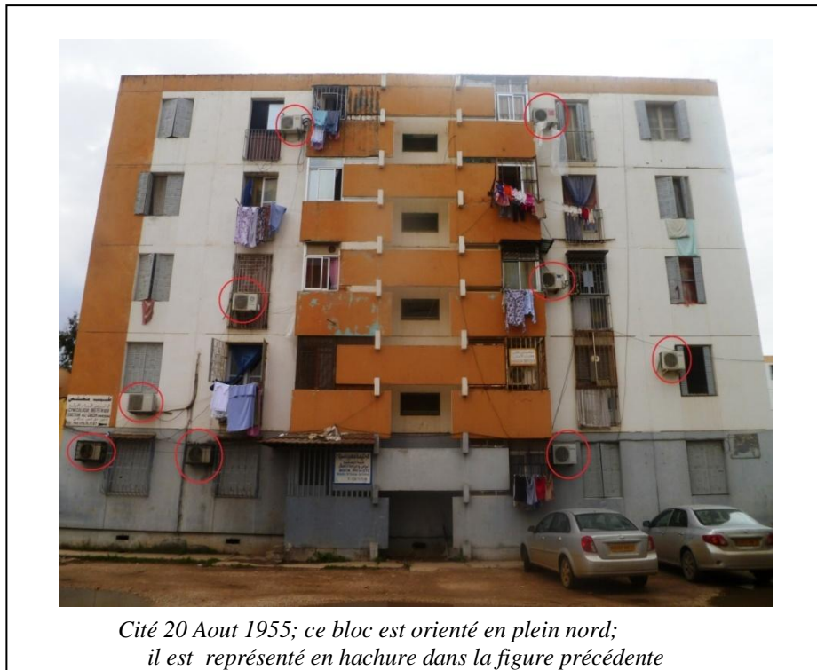
Figure 62. Installation d'appareil de climatisation sur le mur de façade.
