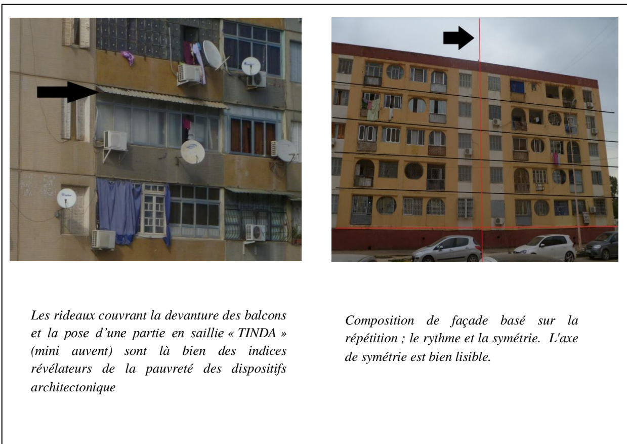
Figure 63. La pauvreté des dispositifs architectonique au niveau des façades du logement collectif.
