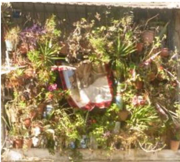
Figure 56. Pose de plante sur le bareaudage du balcon, logement n°39.
