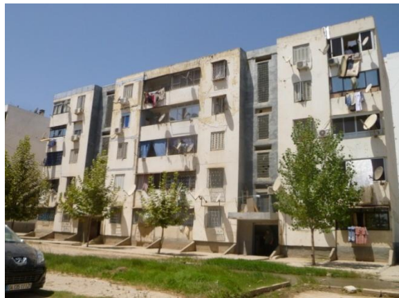
Figure 30. Photo d'un bâtiment "E.S.T.E" les Allées.
