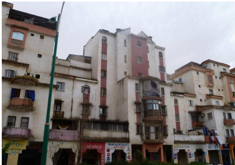
Figure 64. Carences et malfaçons vite remarqué sur les façades des nouvelles cités d'habitation.
