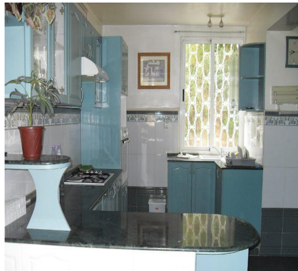
Plan de travail en marbre ,avec un revêtement mural en faïence, logement n°18.
