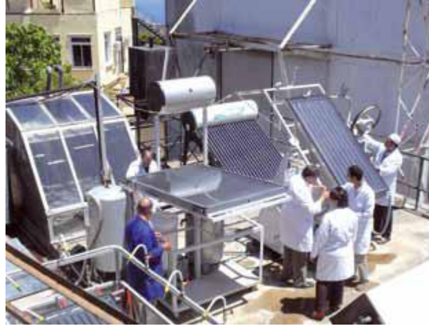
Fig. 1.12 Vue générale de la plate forme d'expérimentation des capteurs solaires thermiques et du chauffe eau solaires au CDER, Bouzaréah-Alger.
