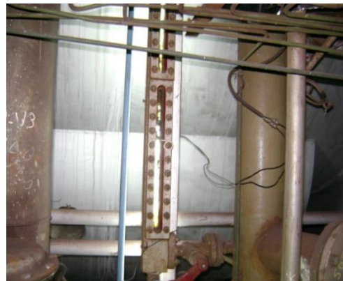
Fig. j : Niveau visuel condenseur
