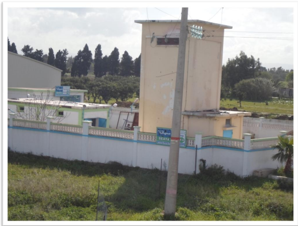
Figure 6. Photographie montrant la station de relevage des eaux destinées de la STEP.
