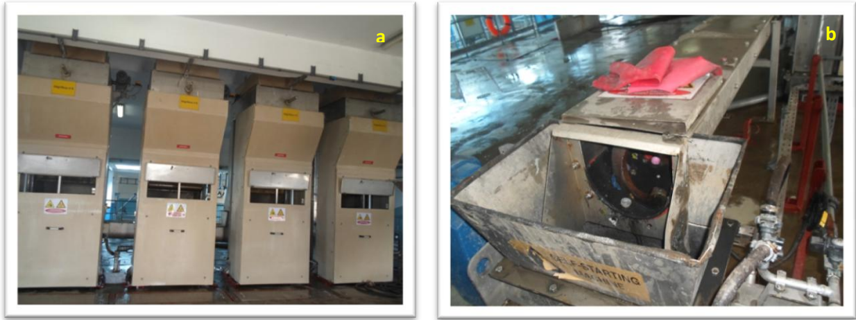
Figure 8. Photographie de 4 unités de dégrilleurs (a) pour l'élimination des gros déchets et leur sortie (b).
