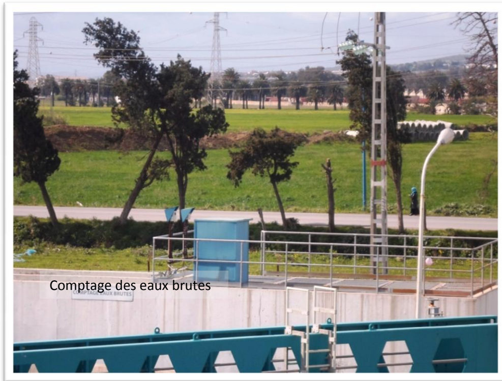
Figure 7. Photographie montrant le débitmètre pour le comptage des eaux brutes à l'entrée.
