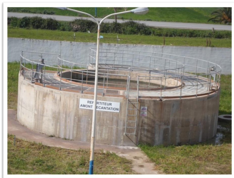
Figure 10. Photographie montrant le bassin répartiteur d'eaux usées vers les bassins de traitement I aire
