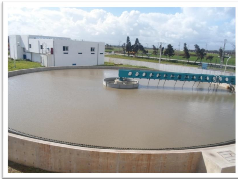
Figure 11. Photographie montrant un des bassins de décantation
