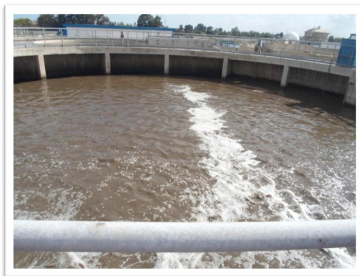
Figure 12. Bassin de relevage permettant l'homogénéisation des eaux décantées.
