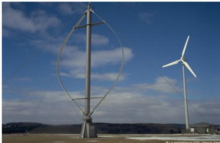
**Fig. 1.11** Éoliennes à axe vertical et à axe horizontal [19].
