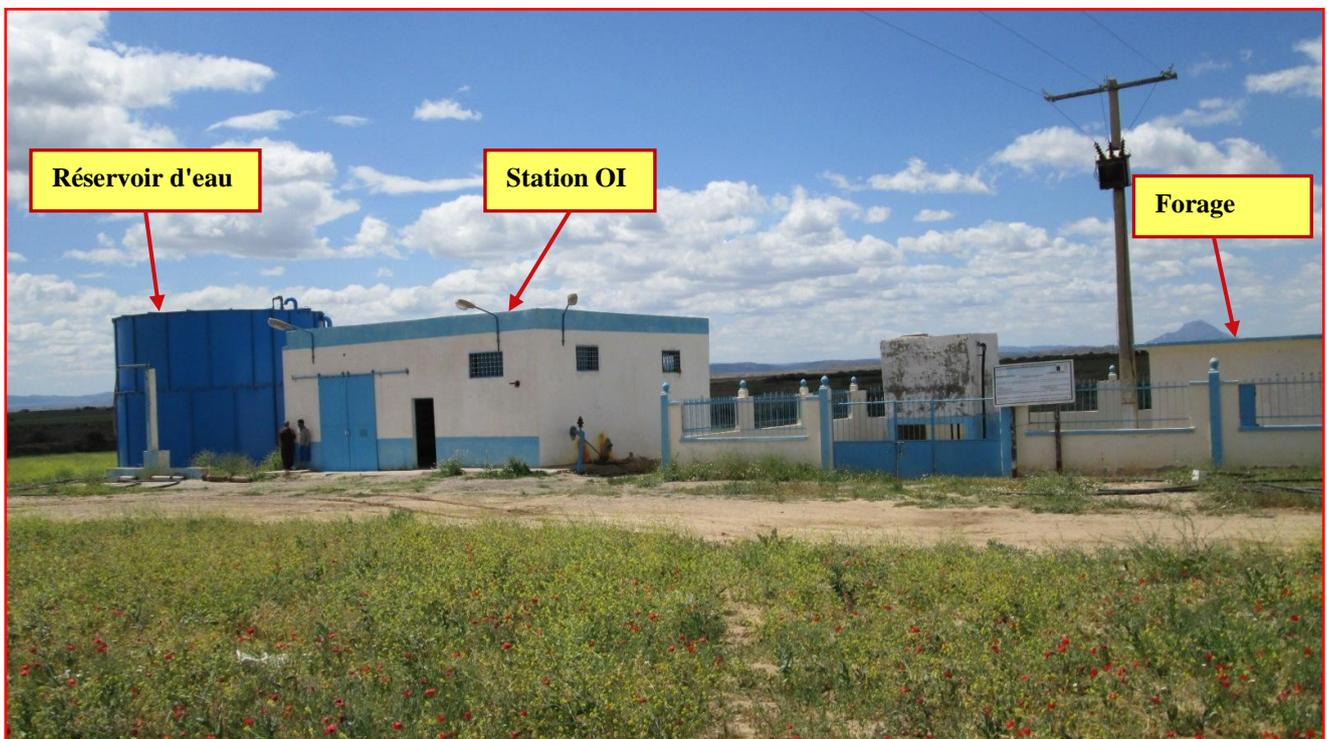
Figure 54: Station de déminéralisation des eaux de à l'osmose inverse d'Oueld Abbas
