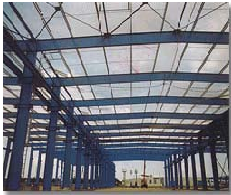
FIG2.2 Exemple2 d'utilisation des PRS
