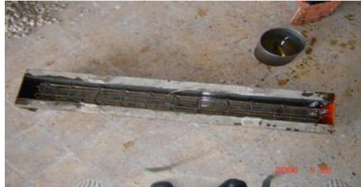
fig (4-9) : Moule équipé de ferrailage
