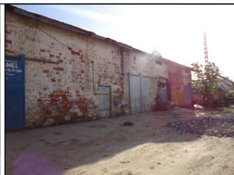
**Figure 156 :** Enveloppe à remplissage en brique rouge. Source: Auteur.
