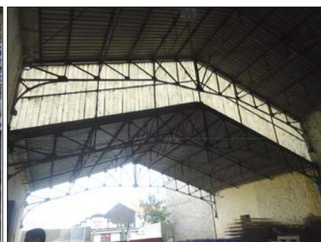
Figure 111: L'éclairage à travers un pignon en verrière. Source: Auteur.
