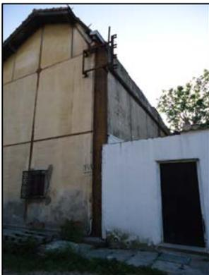
Figure 200: Enveloppe composée de poteaux reconstitué, lisses et potelets). Source: Auteur.
