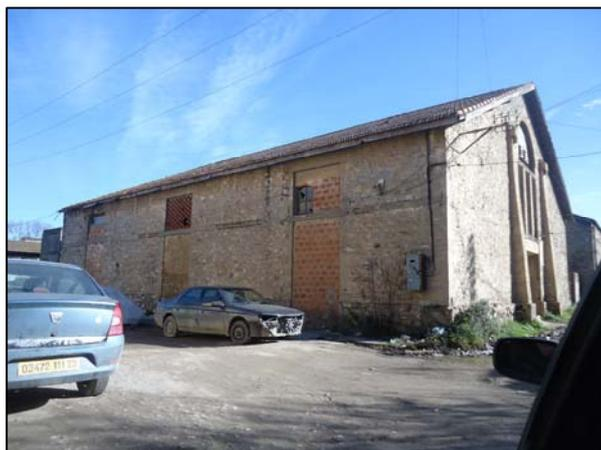
**Figure 174:** Façade latérale à remplissage en brique et en pierre .Source: Auteur.
