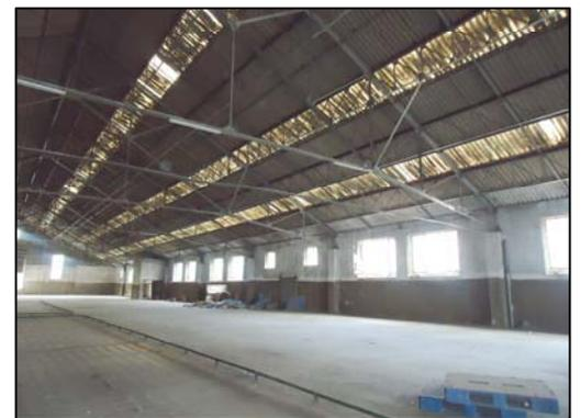
**Figure 72:** Vue sur le bardage intérieur sous toiture en tôle métallique et plastique quasi transparente. Source: Auteur.
