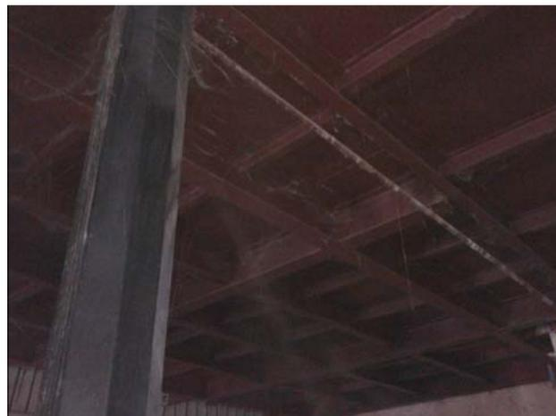
**Figure 132:** L'ajout d'un nouveau plancher métallique à caissons (modification récente). Source : Auteur.
