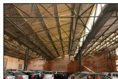
Figure 39: Usine TABACOOOP- Bâtiment 1- Bâtiment d'angle- toiture en sheds portée par une structure métallique. Source: Auteur.
