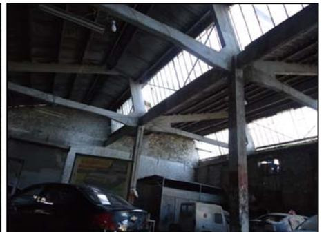
**Figure 167:** Eclairage par toiture en sheds. Source: Auteur.
