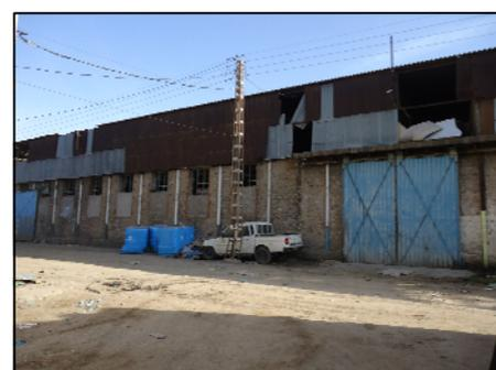
**Figure 160:** Remplissage du mur en pierre et encadrement des baies en brique pleine. Source: Auteur.
