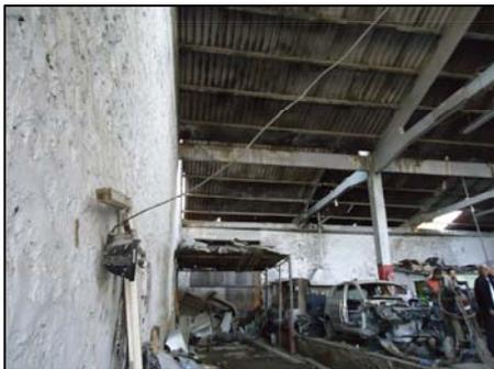
**Figure 165:** Bardage en tôle métallique ondulée. Source: Auteur.
