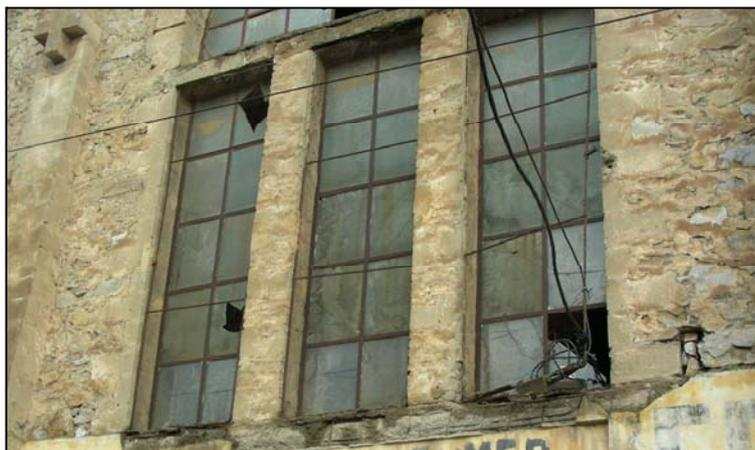
**Figure 173:** Fenêtres verticales à encadrement en bloc de ciment Source: Auteur.
