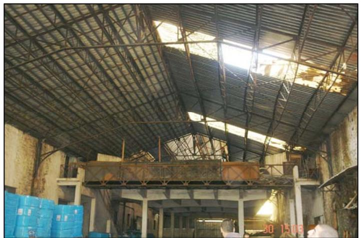
**Figure 108:** Vu sur la toiture en treillis et l'éclairage
