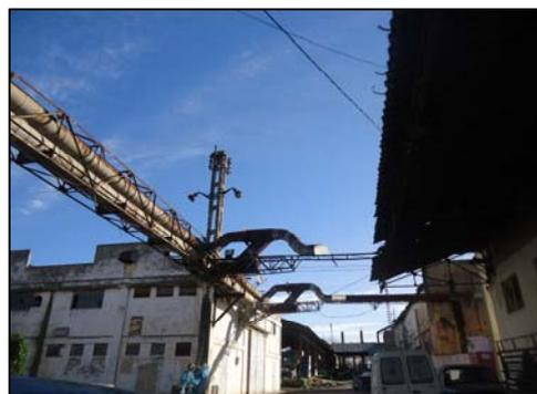
Figure 221: canalisation liant les bâtiments 4 et 2. Source: Auteur.
