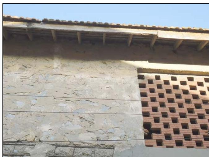
**Figure 176:** Bardage sou toiture et chevrons en bois. Source: Auteur.
