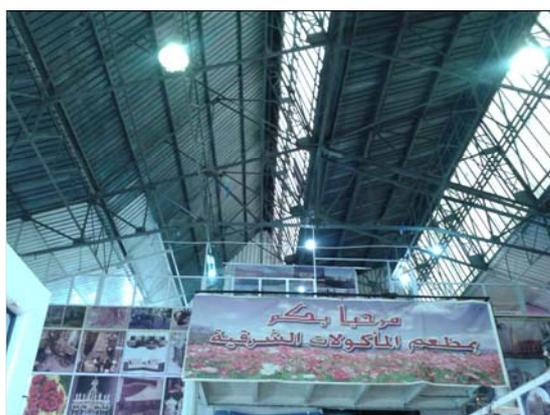
**Figure 128:** Vue sur la structure en treillis métallique. Source: Auteur.
