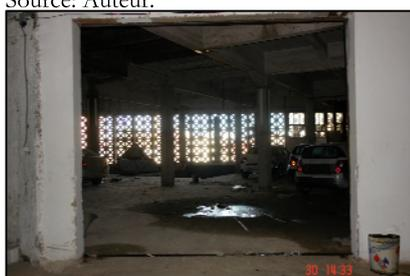
Figure 40: Usine TABACOOOP- Bâtiment 1- Bâtiment d'angle- Eclairage naturel par des claustra. Source: Auteur.
