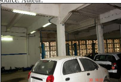
Figure 41: Usine TABACOOOP- Bâtiment 1- Bâtiment d'angle- Structure poteau-poutre en béton armé. Source: Auteur.
