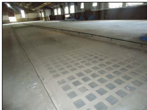
**Figure 71:** La fermeture de la mezzanine par des nivadas- Modification ancienne. Source: Auteur.
