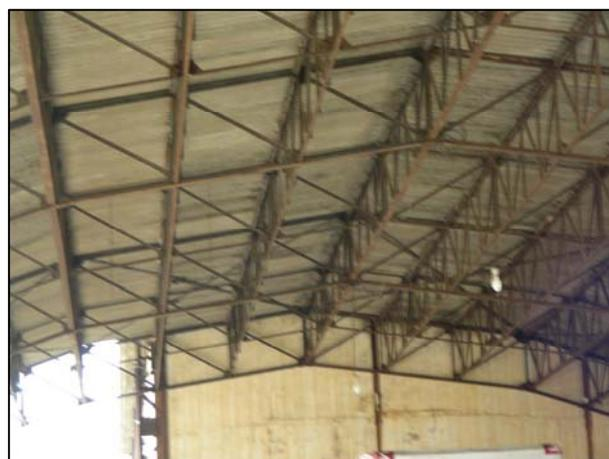
**Figure 195:** TOMACCOOP. Bâtiment 3. Structure en treillis métallique et couverture en tôle- Etat actuel.
