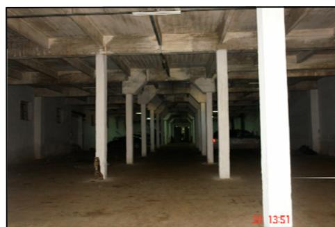
**Figure 78:** Usine TABACOOP- Bâtiment 1- Dock 3-structure poteau-poutre en béton armé- rez-de-chaussée- état actuel. Source: Auteur.
