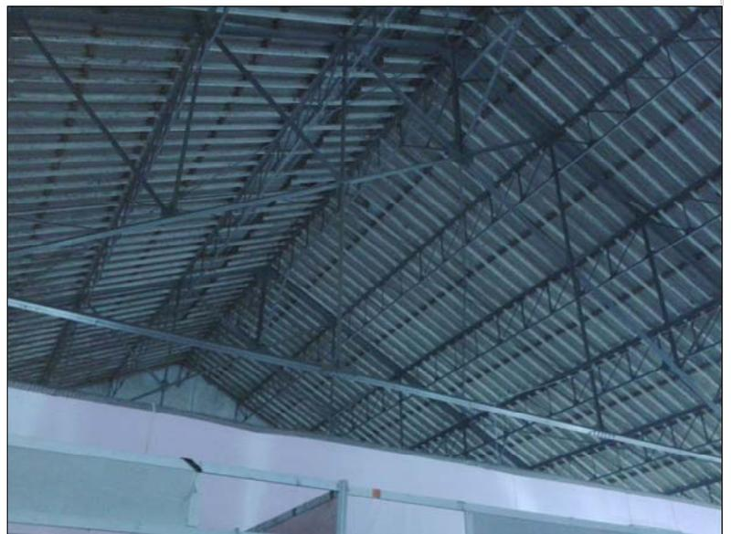
**Figure 96:** Dock 4- La structure métallique en treillis à tirants. Source: Auteur.
