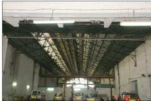
**Figure 118:** Vue générale sur la structure en treillis et le toit en sheds. Source: Auteur.
