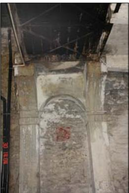
**Figure 120:** Structure voûtée en béton armé portant la passerelle. source: Auteur.
