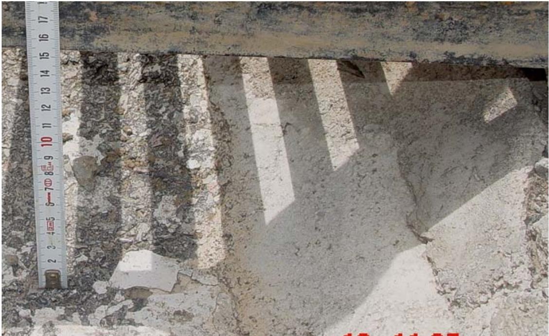
Fig. 34c : Le déplacement est verticale de 16.5 cm, la faille ne s'arrête pas et le glissement s'enfonce encore plus.
