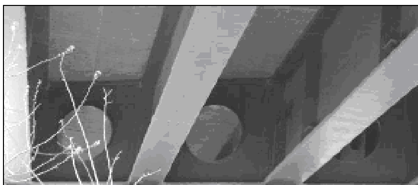
Fig. 1.19 : Exemple d'un quadripoutre avec un diaphragme
