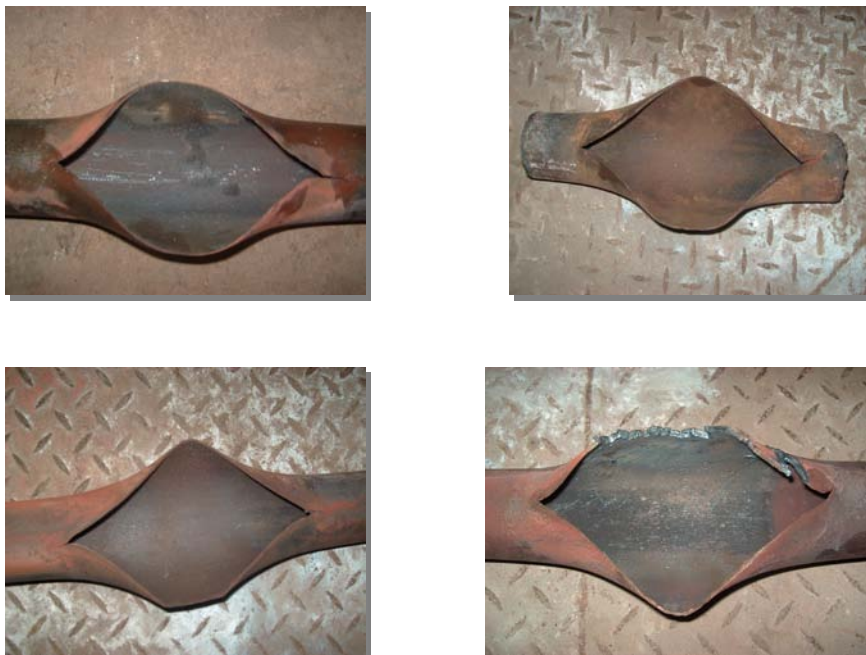
Fig.3.6 Tubes vaporisateurs éclatés "chaudière 40 façade avant février 2005 "[33]
