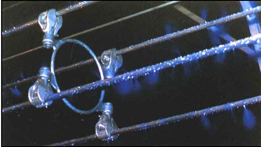
Fig.4.01 Phénomène de l'effet couronne dans les lignes HT. [32]
