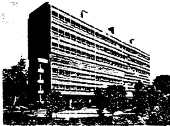
Figure 02, L'unité d'habitation de le Corbusier conçue pour 1000 habitants réalisée a Marseille en 1951, SOURCE BENEVOLO 1971, p440
