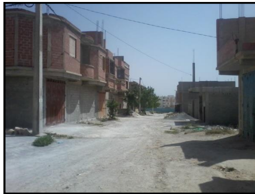
photo 19, voiries non viabilisées, lotissement ENNAHDA,
