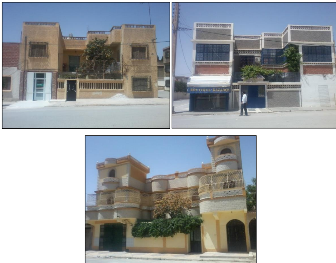
Photo 36, 37, 38 , Façades identiques, avec matériaux de revêtement différents, lotissement EL AMAL source enquête personnelle 2013
