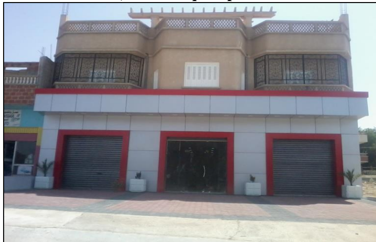
Photo 29, l'utilisation de l'halucobande pour la façade de la construction, lotissement Omar ben khattab, source enquête personnelle 2013
