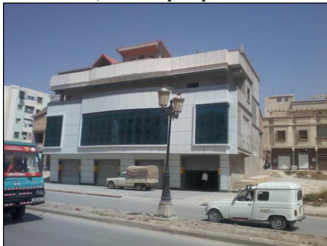
Photo 30, l'utilisation de l'halucobande pour la façade de la construction, lotissement ENNAHDA, source enquête personnelle 2013
