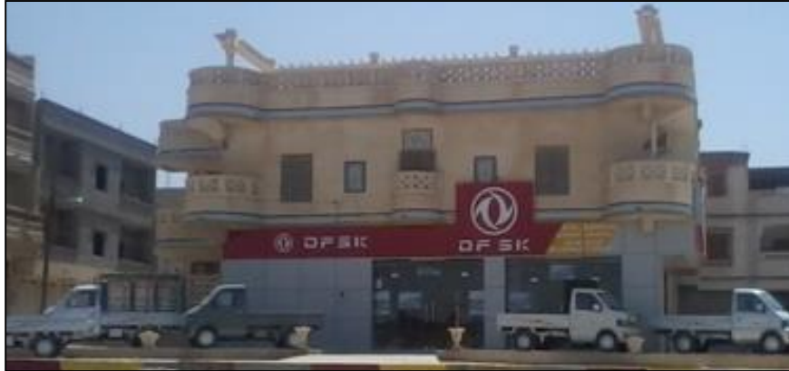
Photo 28, l'utilisation de l'halucobande pour la façade de la construction, lotissement Omar ben khattab, source enquête personnelle 2013
