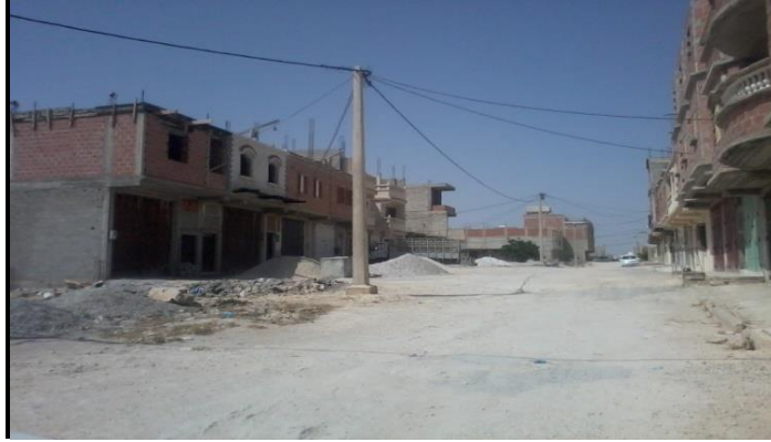
photo 16, ENNAHDA, un grand chantier, enquête personnelle 2012
