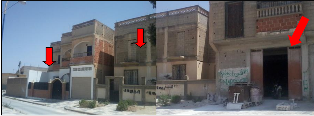
photo 22, avancement de construction au dépouillement de l'espace réservé au jardin, source enquête personnelle 2012
