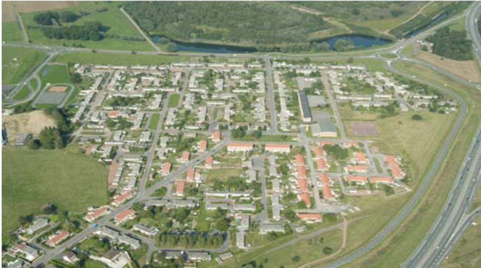
Photo n° 05 : Cité du Bois Duriez à LALLAING Source : l'habitat minier en région nord - pas de calais Mission bassin minier Nord pas de calais Réédition : septembre 2008
