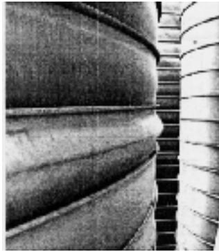
**Fig 16** : Flambement au dessus de support des parois des silos à bague raidie. [19]
