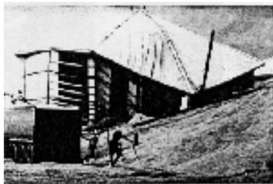
**Fig 12 :** Éclatement d'un silo à assemblage mal détaillé. [19]
