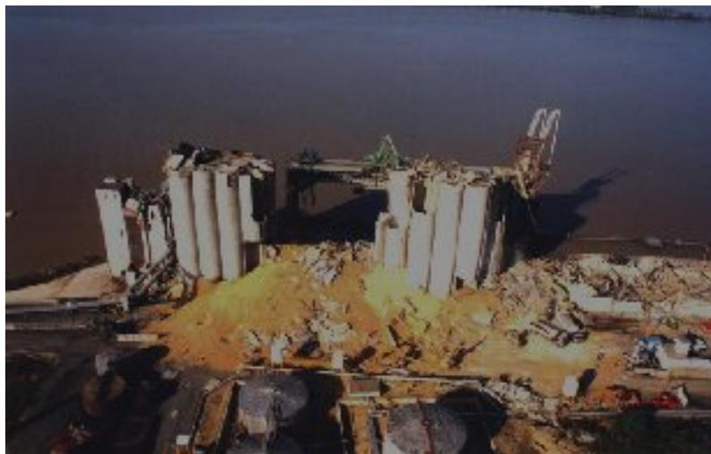
**Fig 2 :** Des accidents des silos. [5]
