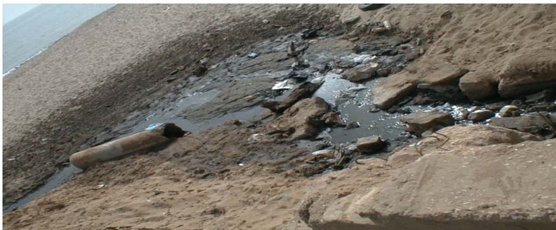
Figure 52: Photographie montrant un déversement d'eaux usées directement dans le littoral.
