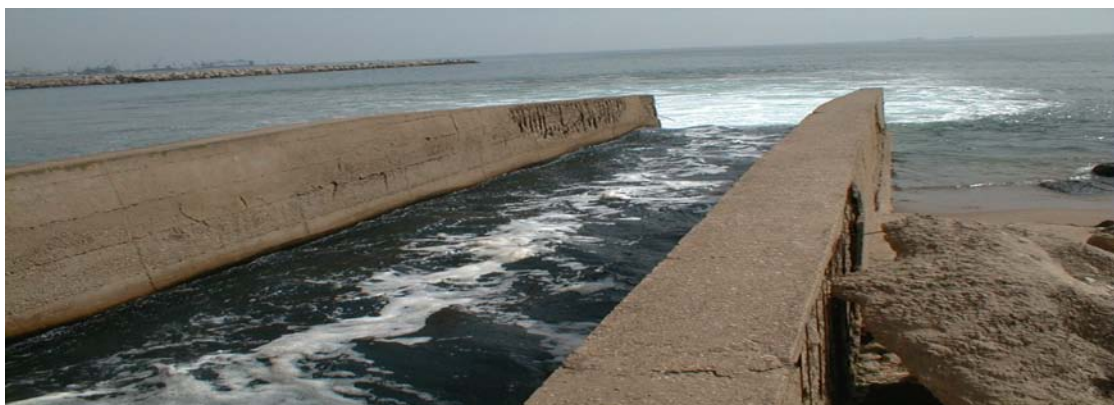
Figure 51: Photographie montrant le principal rejet d'eaux de refroidissement d'Asmidal.
