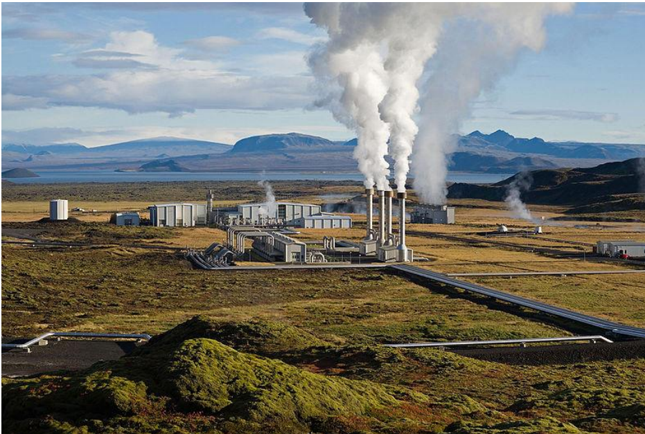
Figure I- 11: Centrale géothermique de Nesjavellir en Islande
