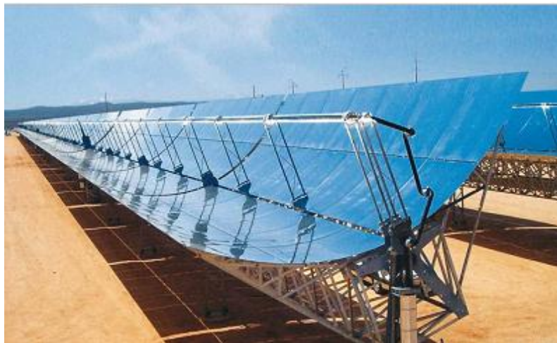
Figure I- 8: Centrale constituée de capteurs cylindro paraboliques
