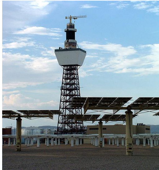
Figure I- 10: Centrale solaire à tour (Solar Tower en Californie)
