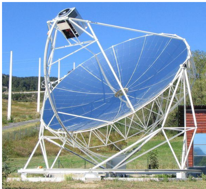
Figure I- 9: Centrale solaire parabolique (projet DISH-STIRLING à Font-Romeu-Odeillo)
