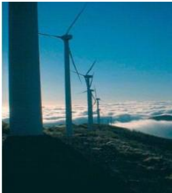
Figure I.6 : Photo d'une centrale éolienne
