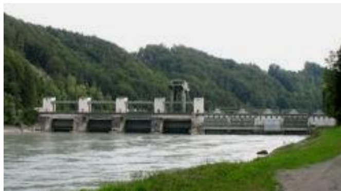
Figure I.5 : Photo d'une centrale hydroélectrique en Allemagne
