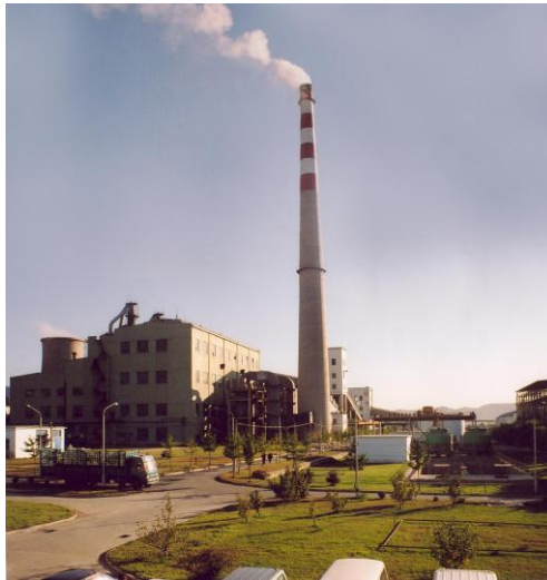
Figure 1.2 : Photo d'une centrale thermique
