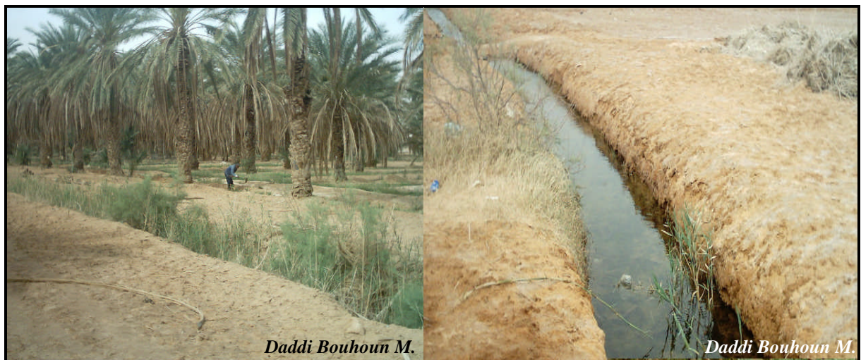
Photo V 1. Drain et collecteur principal mal entretenus à Mékhadma
