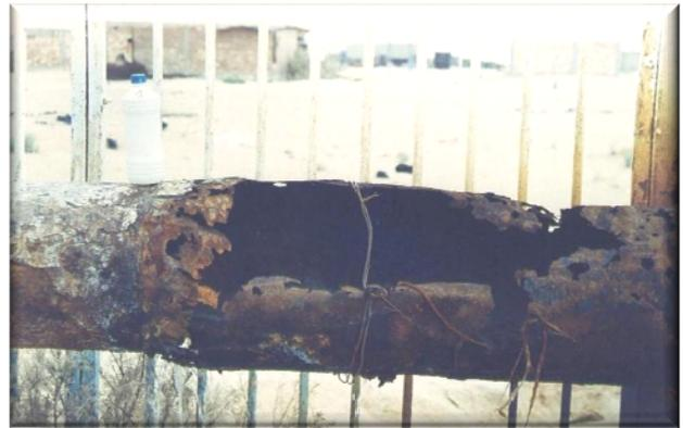
Photos V-02 : Les canalisations sont détruits par corrosion
