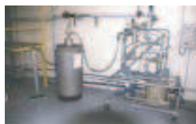
Compresseur à éjection de vapeur
