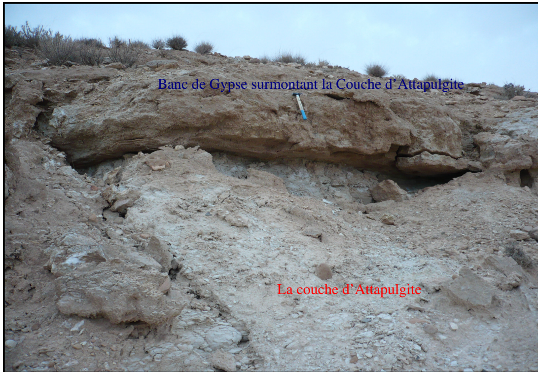
Fig.59- présence de banc de gypse surmontant la couche d'attapulgite
