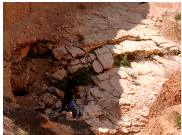
Photo de l'intérieur de l'affaissement
