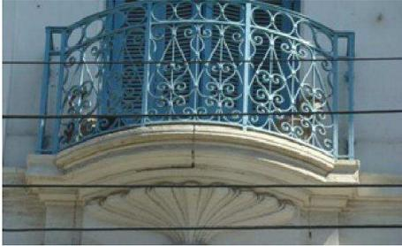
Figure 4 : balconnet en fer forgé
