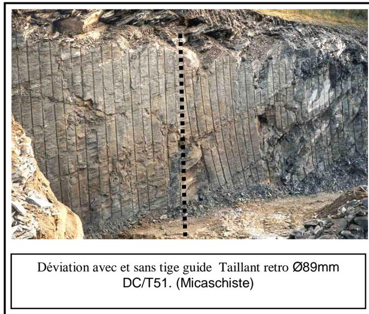
Fig.1.22 : Schéma de foration avec et sans tube guide. <sup>[31]</sup>
