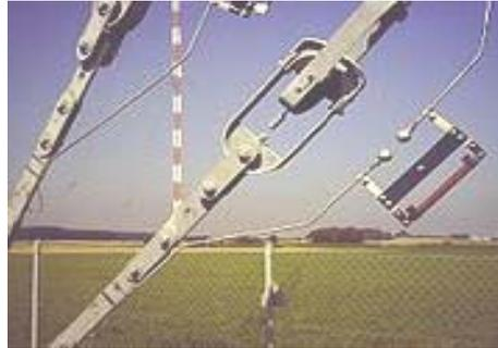
Figure 1.16 : Photo d'un éclateur à air.
