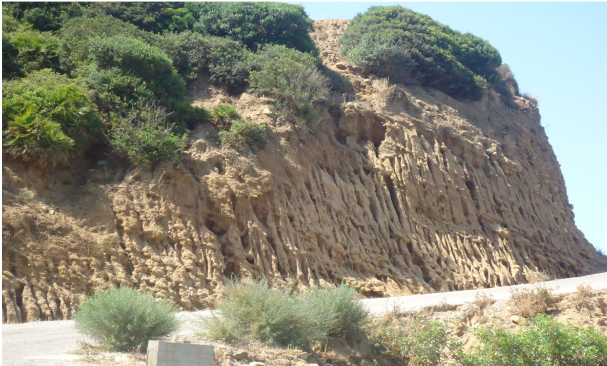
Image n° 23 l'érosion à Chetaibi –route menant à la plage Sidi Akacha-
