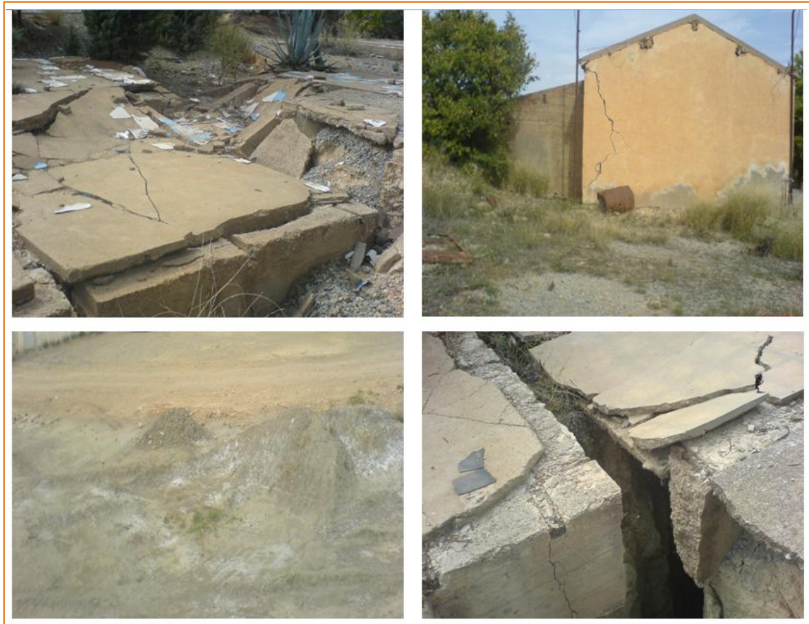
Fig. 1.10 : Observation de fractures et de fissures au-dessus des anciens travaux miniers, Mine Kherzet Youssef (BOUKELLOUL.M.L, 2007).
