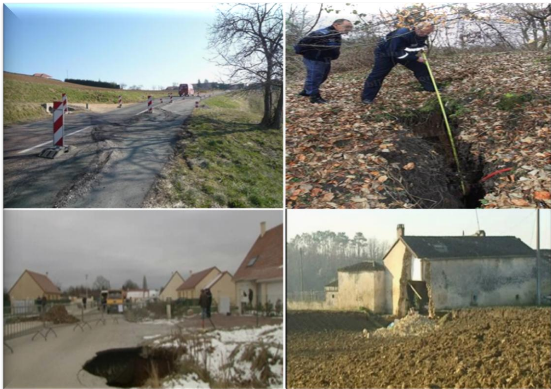
Fig.1.9 : Affaissement et effondrement de la mine Varangéville, France (Bennani M., et all 2004).
