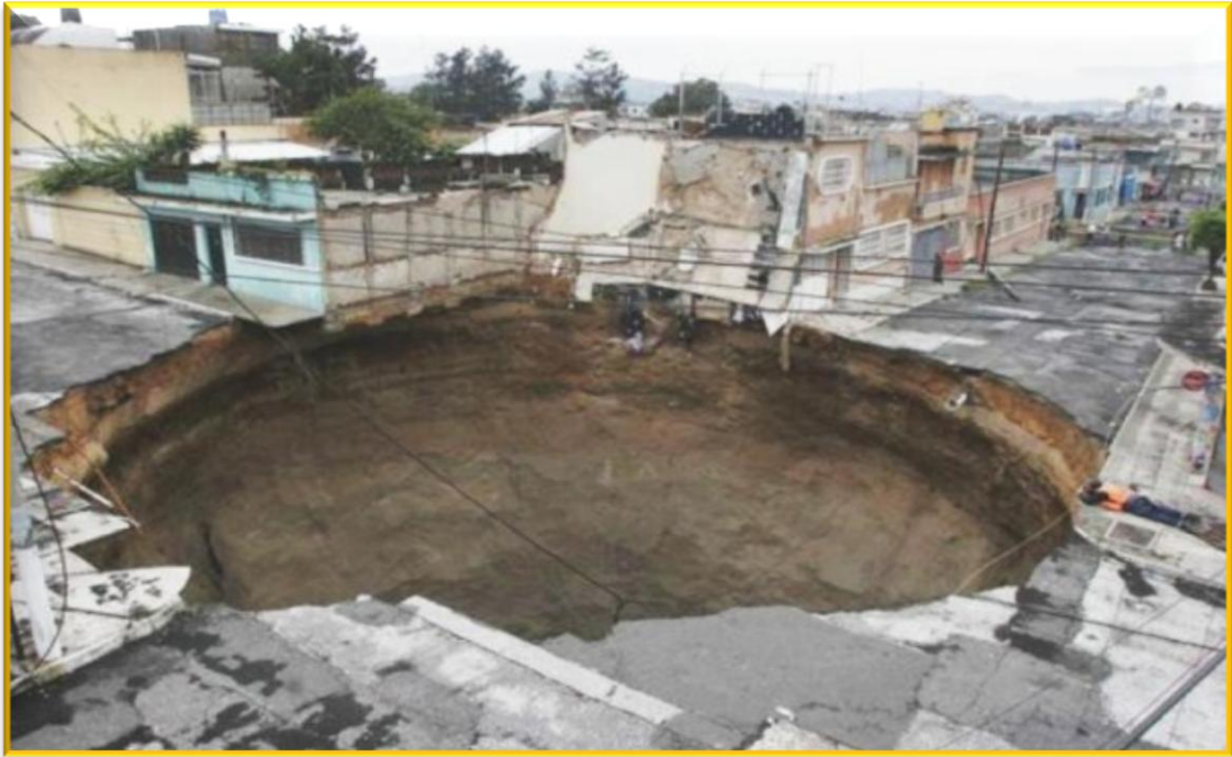
Fig.1.8 : Effondrement de la mine Bodovalle, Espagne (RAMÍREZ OYANGUREN P, LAÍN R, 2003).
