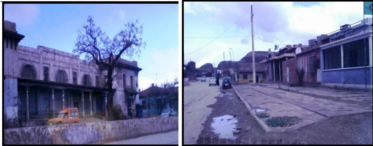
Figure 3 : Etat de dégradation des constructions.
