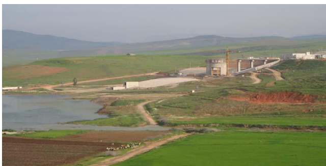
Figure 6 : Station de pompage dans le barrage Beni-Haroun.
