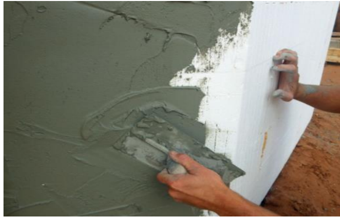
Figure 4.11 : Application des enduits (Armand et Rafestin, 1999)
