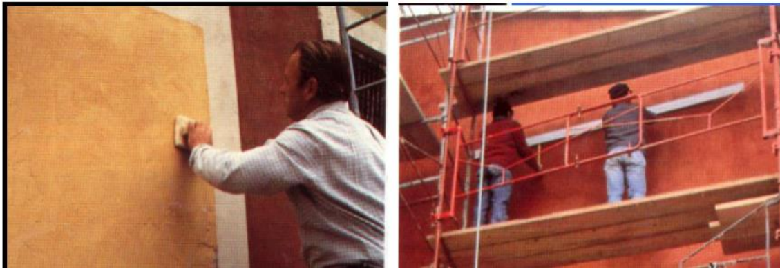
Figure 3.7 : Enduit extérieur d'un mur (Venise et al, 2011)
