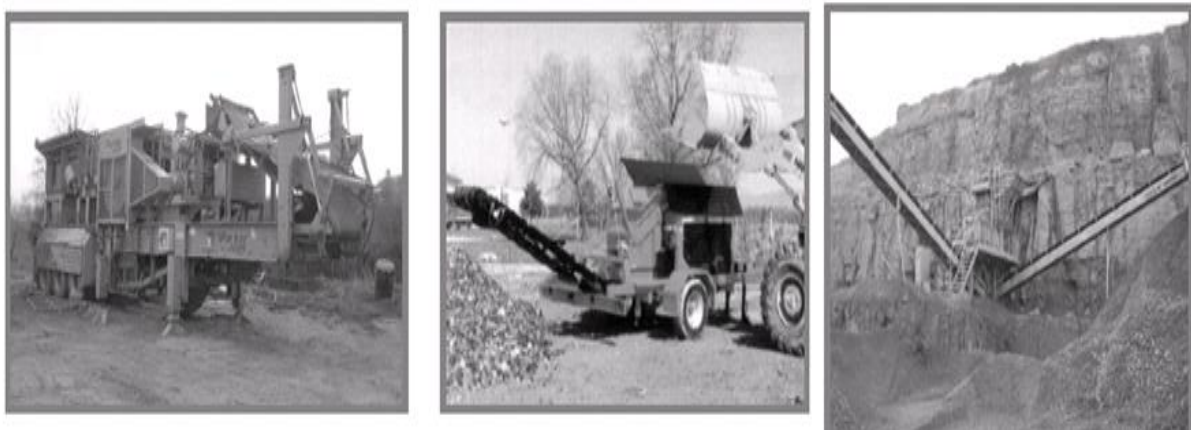
Figure 2.14 : Concassage des granulats à l'aide des concasseurs à mâchoires (Dupain et al, 2004)
