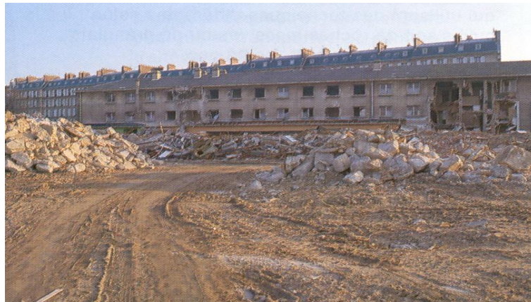
Figure 2.11 : Les matériaux de démolition issus des bâtiments (Vimane, 2006)
